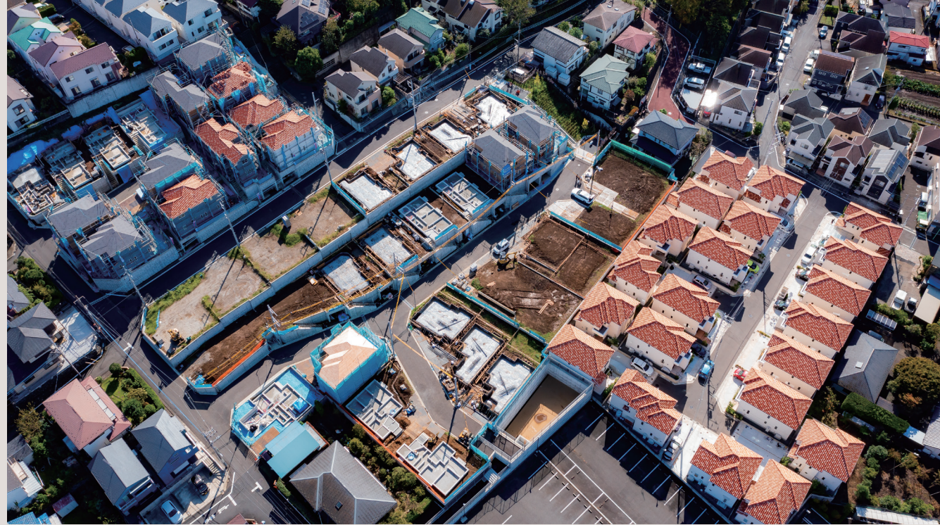
右側のオレンジ色の屋根が完成した21棟。中央から左は、現在建築中の残り44棟。全ての完成は来年春の予定です。
